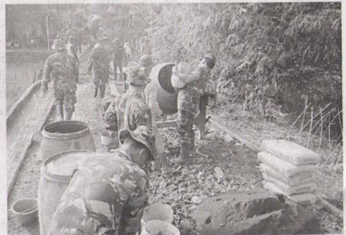
COR JALAN: Anggota TNI Kodim 0715/Kendal bersama masyarakat bergotong royong menggarap program fisik berupa pengecoran jalan dalam kaitan TMMD. ■ Foto: Agus Umar/SR
