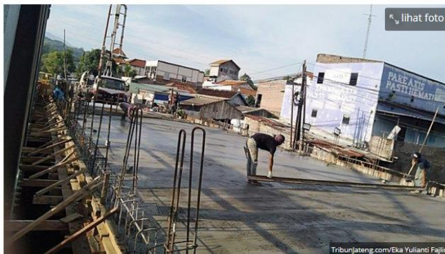
Pekerja mengecor jembatan besi Sampangan, Rabu (23/12/2020) lalu. Kini, proyek pembangunan Jembatan besi Sampangan sudah mengalami putus kontrak lantaran pihak kontraktor tak dapat menyelesaikan hingga masa kontrak habis.
