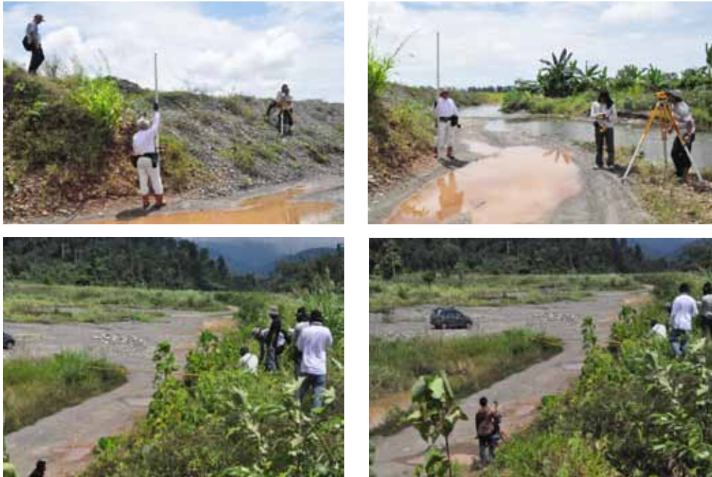
Gambar 4.1. Pengujian Volume Pekerjaan Pembangunan Tanggul Banjir Sungai Kasi (Tahap II) Kabupaten Manokwari Menggunakan Waterpass dan Theodolite
